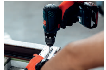
Montage mit akkubetriebenen Elektrowerkzeugen
